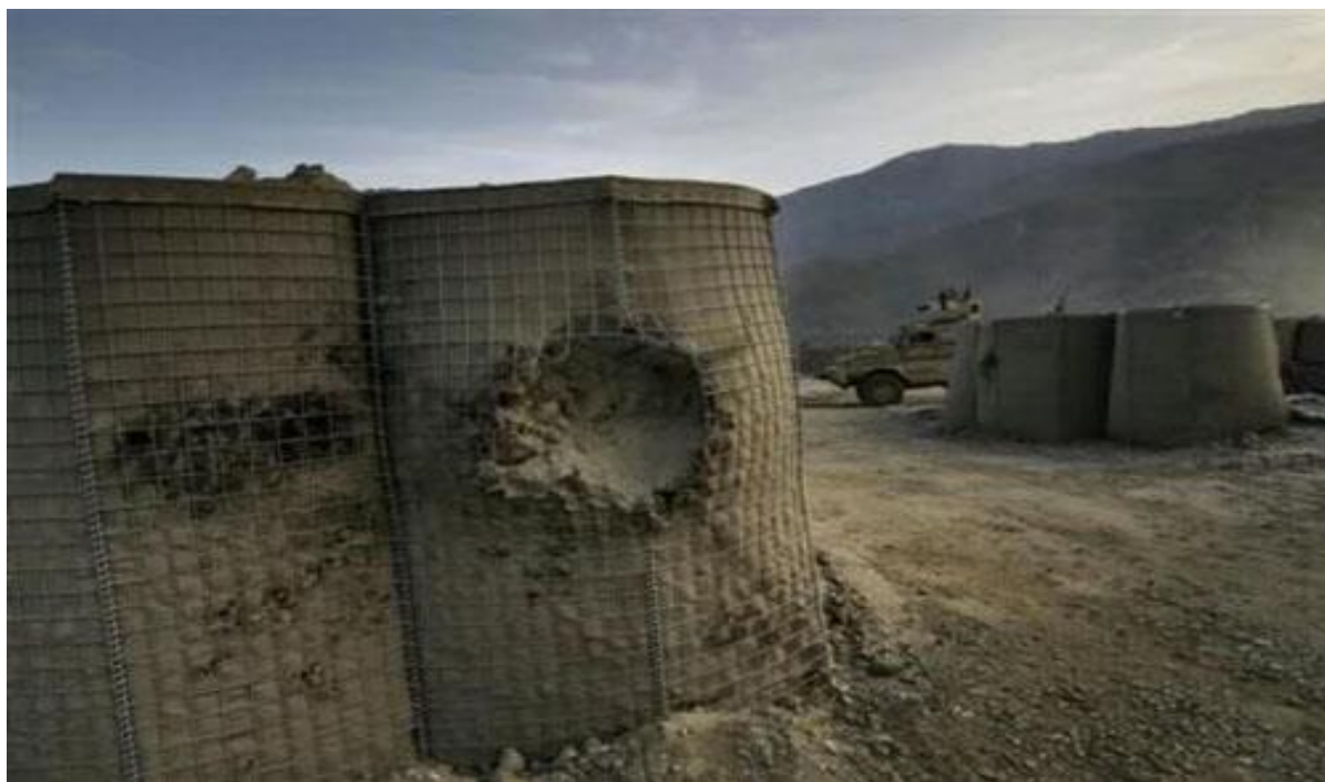
Рисунок 4 – Повреждение габионов от противотанкового гранатомета
