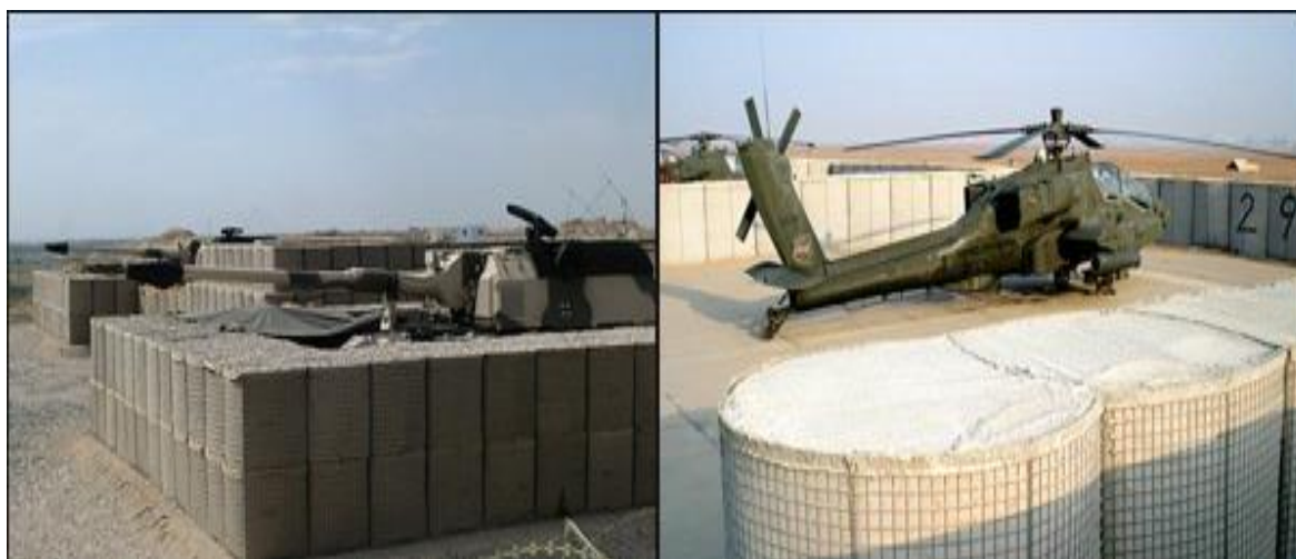
Рисунок 2 – Защита вертолетных площадок габионами
